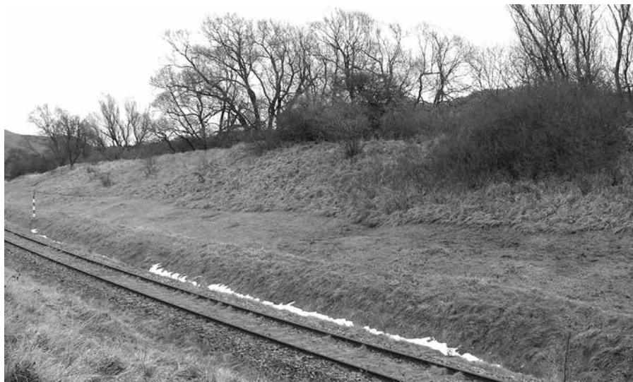
Pohled na část lokality u železniční tratě Děčín – Litvínov, podzim 2012 (foto P. Bultas)
